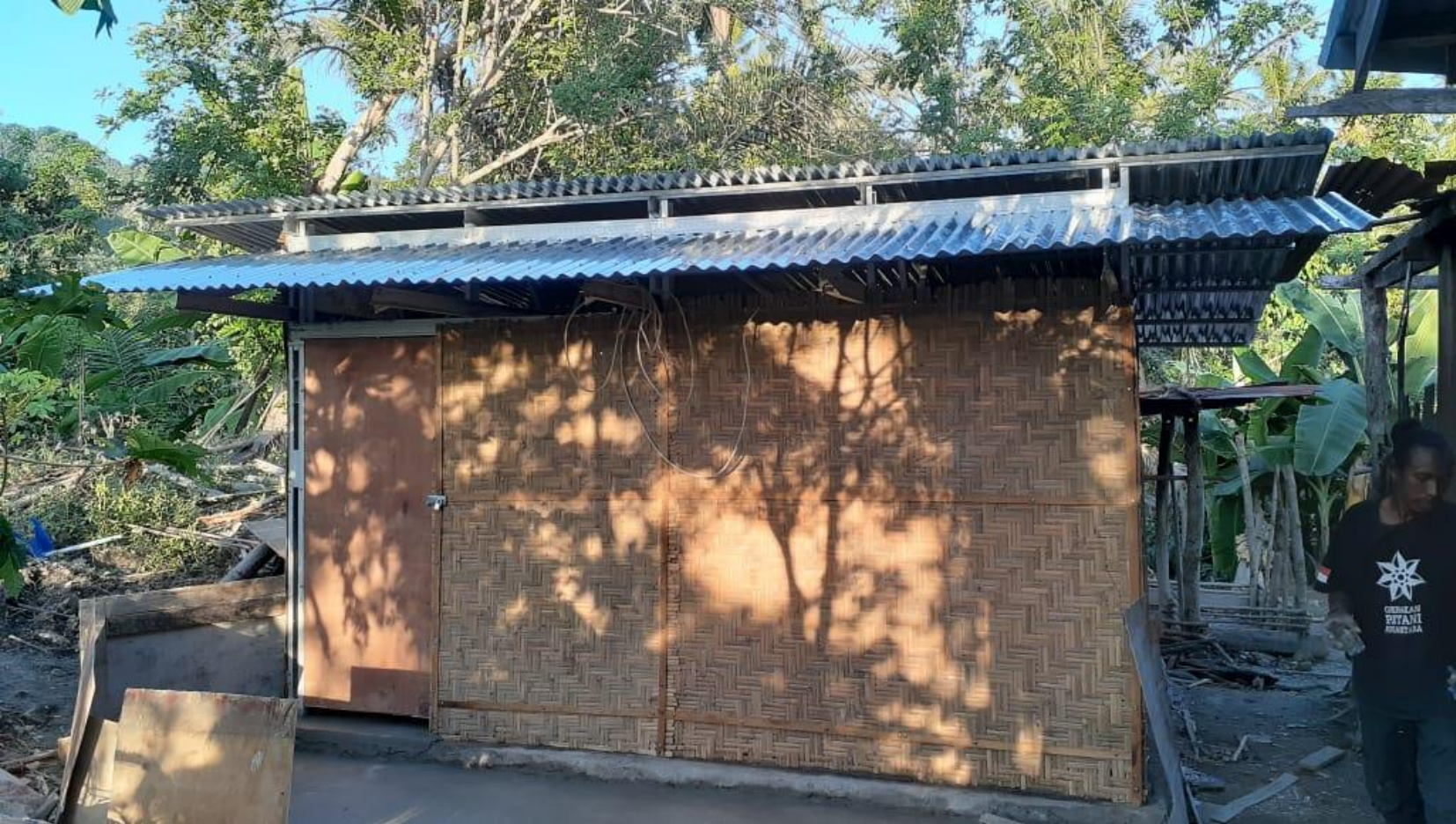
調理場の建設（2021年）
